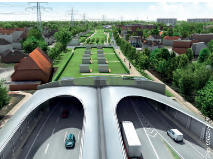
Der Deckel über der A7 ist ein Projekt, das über die reine Erweiterung der Autobahn deutlich hinausgeht und neue Perspektiven schafft.
