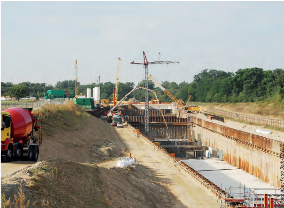
Aufwendige Baustellen finden sich zur Zeit viele links und rechts der A7. Vor allem dort, wo die Deckel entstehen sollen.
