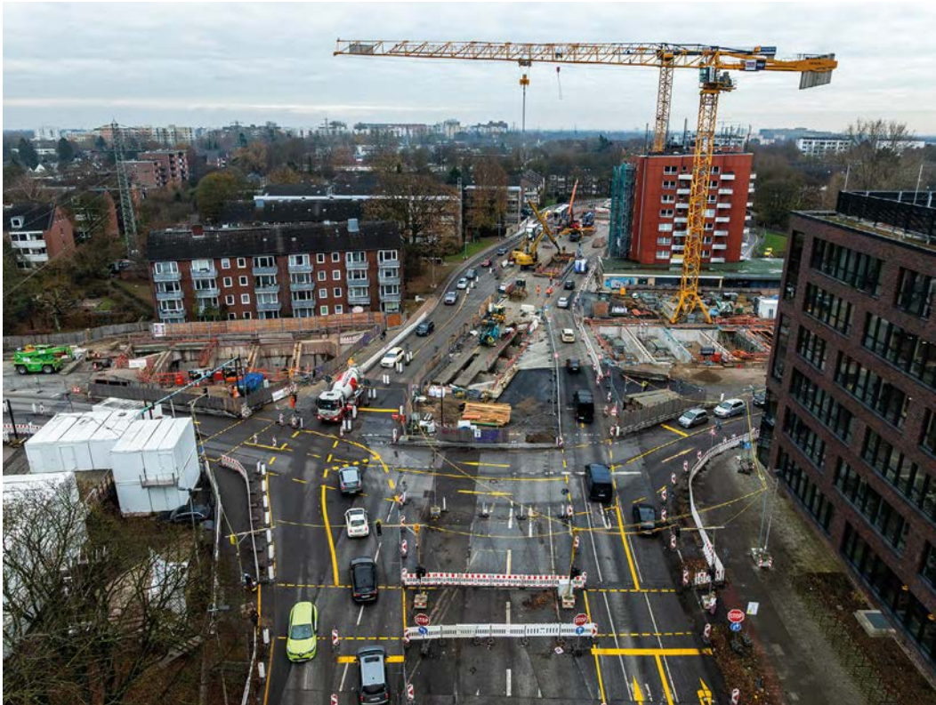
U5-Baustelle in Barmbek
