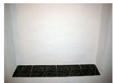
Wand nach der Sanierung von Kefa
