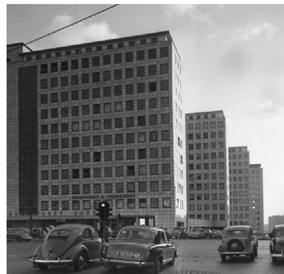
Zwei Bilder, ein Problem: Die Ästhetik des City-Hofs nicht. Und auch wenn sich die Fassade verändert hat:
