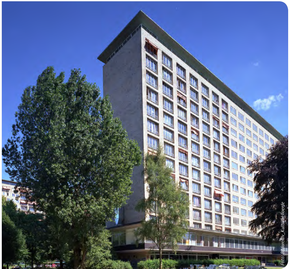
Die Grindelhochhäuser sind ein Beispiel für gelungene Architektur.
