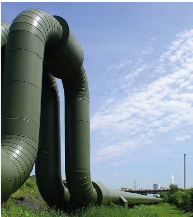
Im Gebäudebestand sollen die Klimaziele unter anderem durch die Umstellung auf regenerative Heizenergie erreicht werden
