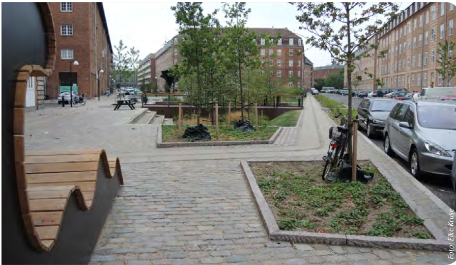
In Kopenhagen verursachten die Regenfluten der letzten Jahre Schäden von eineinhalb Milliarden Euro, jetzt wird intensiv an Schutzmaßnahmen gearbeitet.
