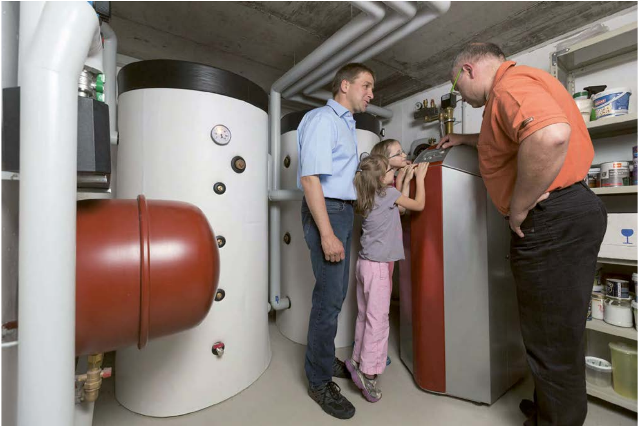
Foto: Bundesverband Wärmepumpe
