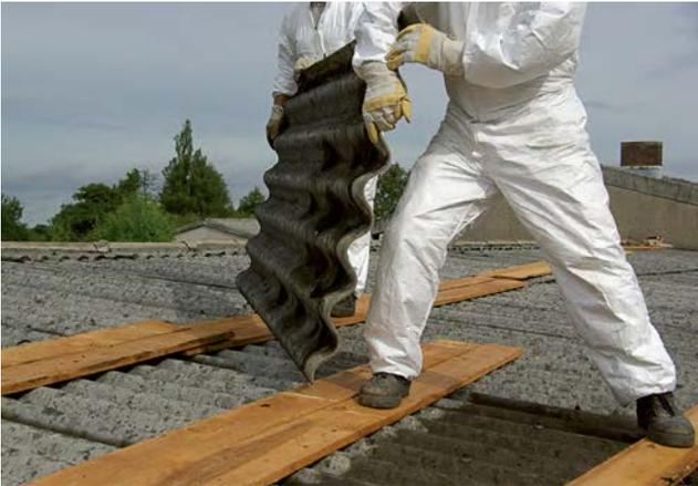
Wird nach einer professionellen Gefährdungsbeurteilung deutlich, dass in einer älteren Immobilie asbesthaltige Baustoffe verbaut wurden, diese eine Gesundheitsgefährdung darstellen und daher entfernt werden müssen, sollte man ein zertifiziertes Fachunternehmen beauftragen. „Wer auch immer den Ausbau und die Entsorgung vornimmt, muss einen Sachkundenausweis nach der TRGS 519 vorlegen können, der nicht älter als sechs Jahre ist“, heißt es beim Gesamtverband Schadstoffsanierung in Berlin.
