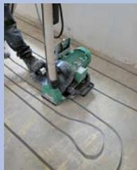
Eine Fußbodenheizung bietet viele Vorteile: Sie sorgt für eine angenehme Wärme im Raum, spart Energie und erhöht den Wert einer Immobilie. **Die gute Nachricht: Durch das Fräsen in den vorhandenen Estrich kann eine Fußbodenheizung auch nachträglich noch problemlos eingebaut werden.**
